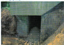
Bunkeringang oostzijde in renovatie
